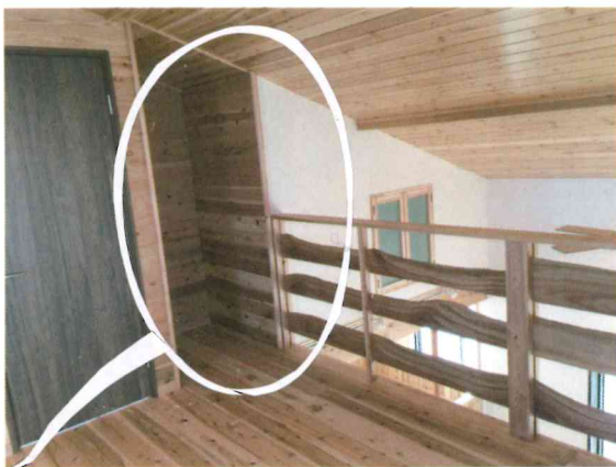
二期工事で扉が付き 四畳半の隠し部屋になっています。
