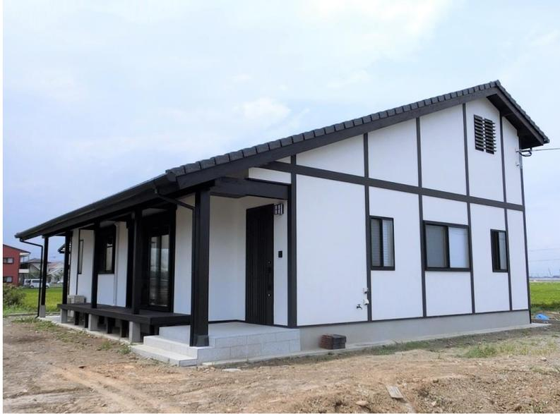
外壁は、付け柱(デザイン上の観点から取り付けた柱)と、自浄作用がありエコロジー材料の、スペイン漆喰を使って
