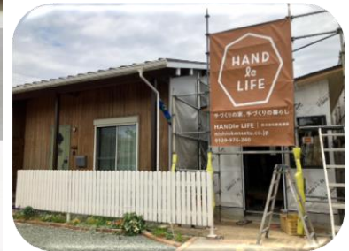
サロン建設中
